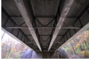
道路橋の橋桁部に鉄鋼以外の金属が使われたのはわが国初めてで、溶接などは当時の先端技術が使われました。
